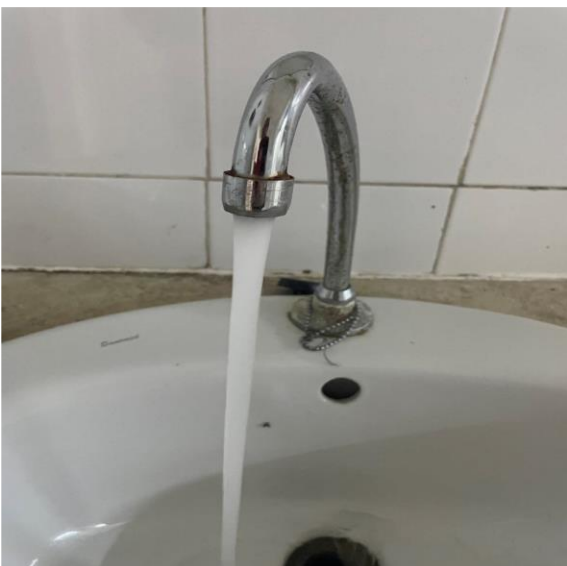
Avant installation des économiseurs
